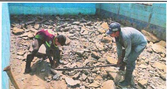
Foto 5: Asi sacamos el antiguo piso del aula
