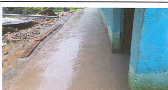
Foto 6: Terminado colocar el piso del aula
