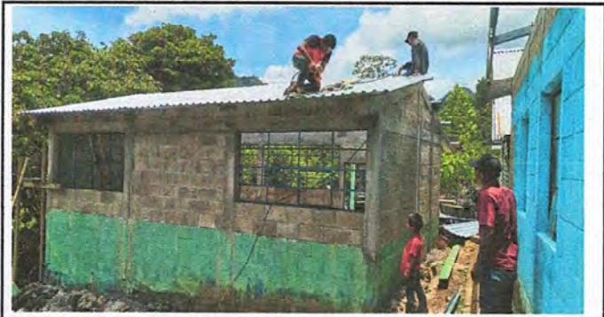
Foto 4: La cocina se esta intalando las láminas
