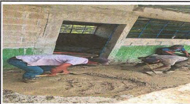
Foto 2: asi se estan colocando el piso de la cocina
