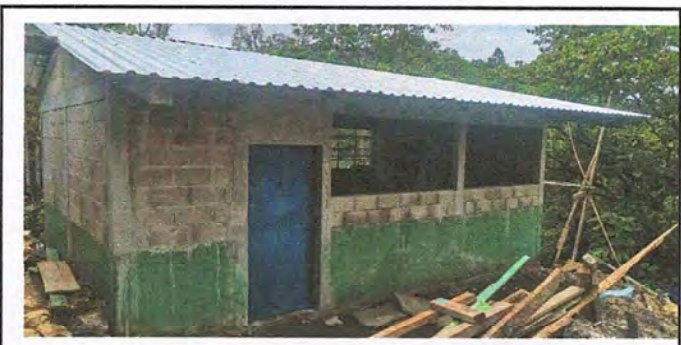
Foto 6: La cocina ya esta entechado
