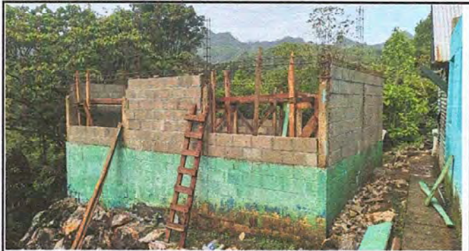
Foto 2: El trabajo se esta poniendo las columnas de la cocina
