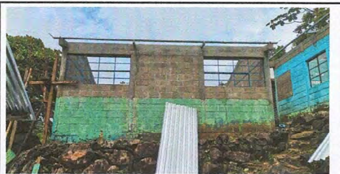
Foto 5: La cocina se esta colocando la puerta y ventanas
