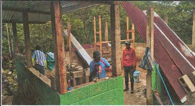
Foto1: Asi se dio inicio el trabajo de remorzamiento de la cocina
